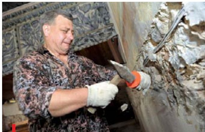
Grzegorz Delmaczyński po godzinach pracy zbija tynki w kościele, żeby można było położyć tzw. tynki renowacyjne
