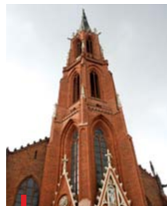
Wieża kościoła pw. Wniebowzięcia NMP w Bielawie ma ponad 100 m wysokości
