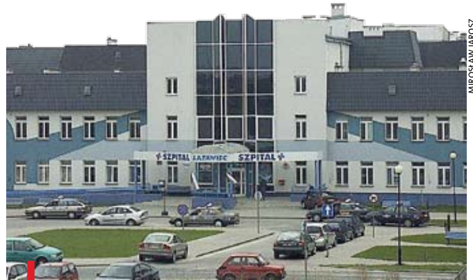
Budowa świdnickiego szpitala trwa od ponad 20 lat
