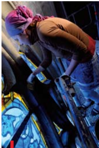
Świdnica. Prace w katedrze zostały spowolnione z powodu braku wsparcia ze strony rządu
