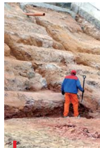
Wambierzyce. Remont schodów bazyliki to największa tegoroczna inwestycja w diecezji
