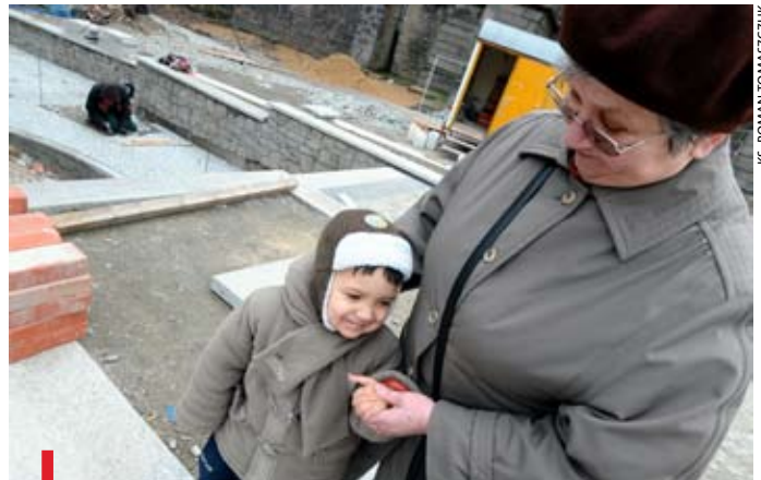
Mały Kuba ze swoją opiekunką panią Anną codziennie sprawdzają stan prac przy budowie placu Jana Pawła II
