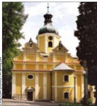
Kościół pw. Narodzenia NMP w Łądku Zdroju
