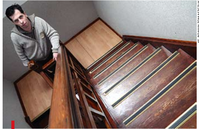
Ostatnio wykonaliśmy remont schodów i klatki schodowej – cieszy się Andrzej Zborowski
