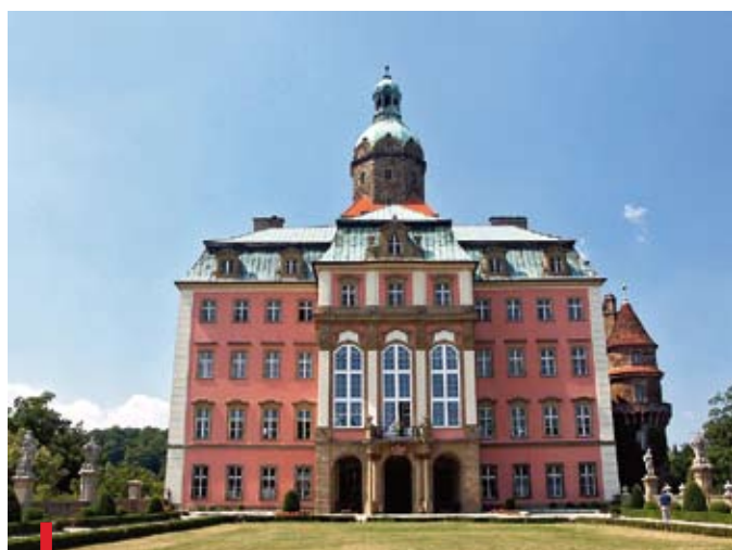
W ramach planu zostanie wyremontowane nieczynne dotąd III piętro Zamku Książ
