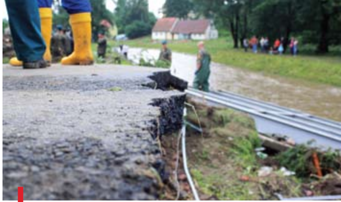
Zerwane mosty utrudniają dojazd do zalanych miejscowości
