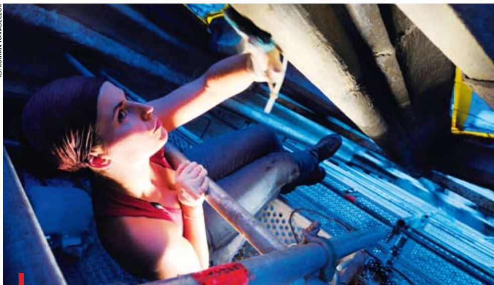
ŚWIDNICA, 18.09.2009 R. Prace przy ogromnym zachodnim oknie katedry świdnickiej prowadzą konserwatorzy z Krakowa
