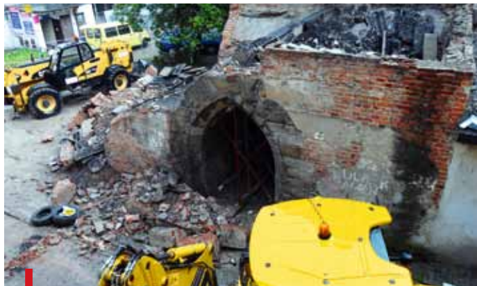
Budowlańcy przystąpili do rozbiórki pozostałości zawalanej wieży
