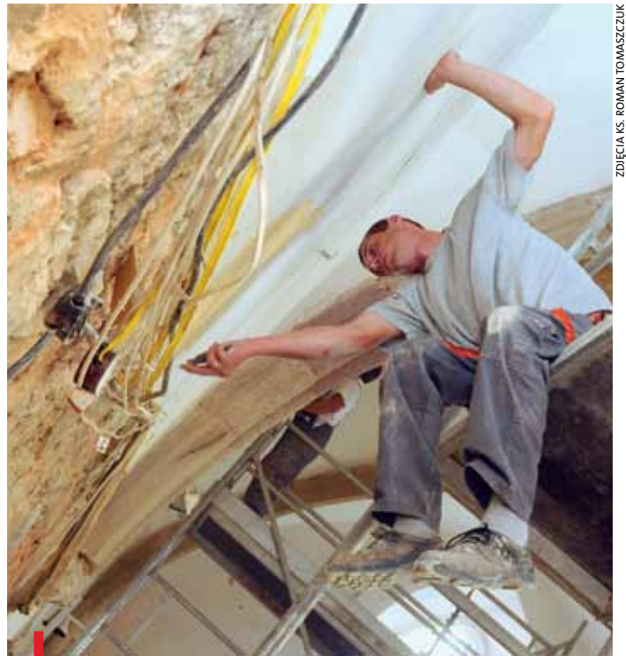
Zbijanie starych tynków to żmudna praca, ale efekt ma być imponujący
